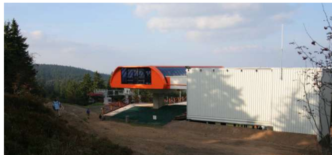
Porosty v PR Hořečky (vlevo nahoře) a PR Pod Vrchmezím (vpravo nahoře) – jarní aspekt. Horní stanice lanovek a terénní úpravy od polského Zieleniece zasáhly NPR Bukačka a výrazně poškozují vnímání zdejšího krajinného rázu.
