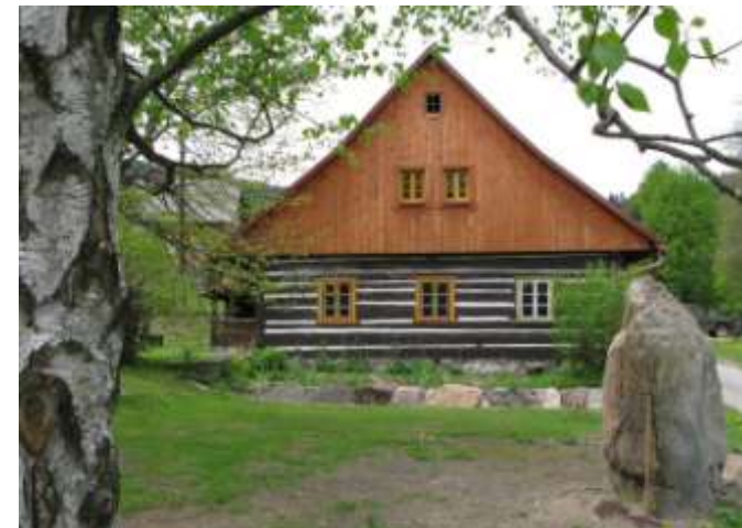
3.-4. Rekonstrukce a údržba původních roubených domů vyžadují úsilí i náklady. Na těchto chalupách je příkladně např. zachování typického zalomení střešních rovin, velikosti a členění oken. Určité došlo k drobným změnám, ale navenek působí velmi autenticky. Konfigurace s bytovými domy, které měly přinést novou kvalitu bydlení na venkov, devastuje dobrý dojem.
