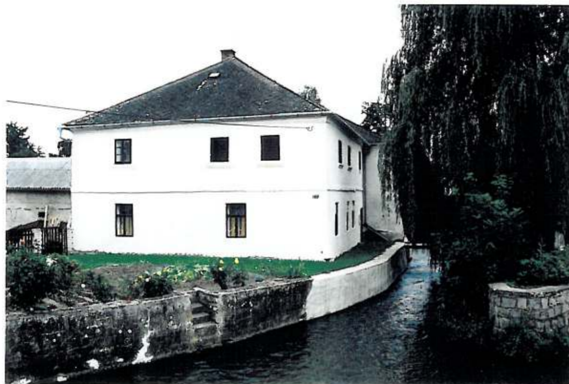
MLADEČ Citlivě zrekonstruovaný objekt bývalého mlýna.
