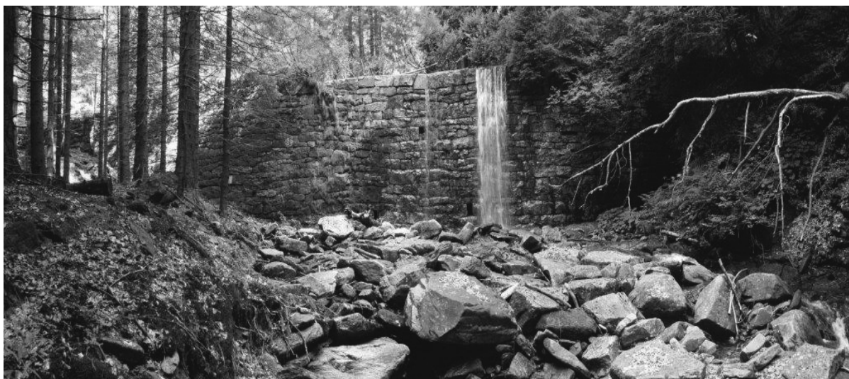
Obr. 3: Závěrečná kamenná přehrážka (zdivo na sucho) v km 5,500 Hučivé Desné, snižující podélný sklon toku a zajišťující paty svahů svahových sesuvů pod Červenou horou – konsolidační objekt o výšce 6 m postavený jako první z objektů pod svahovým sesuvem č. 1 (2014)
