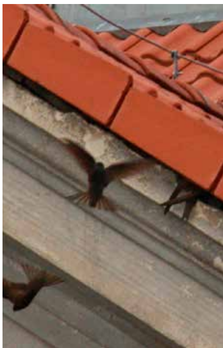
Typickým hnízdištěm rorýsů na starší zástavbě jsou dutiny v podstřeší sedlových střech, kam vletují škvírami pod krytinou, nebo mezerami v římsách. Olomouc
