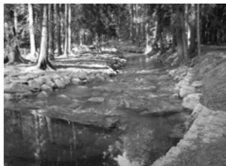
Příklad vhodného provedení migračně prostupného balvanitého skluzu
