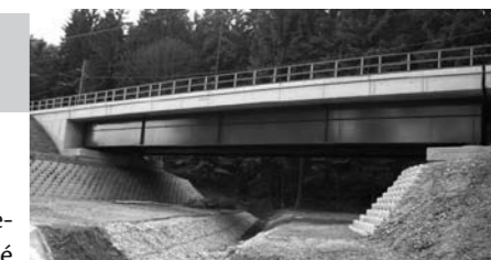
podchod pro zvířata pod železničním koridorem v Dolní Lomné
