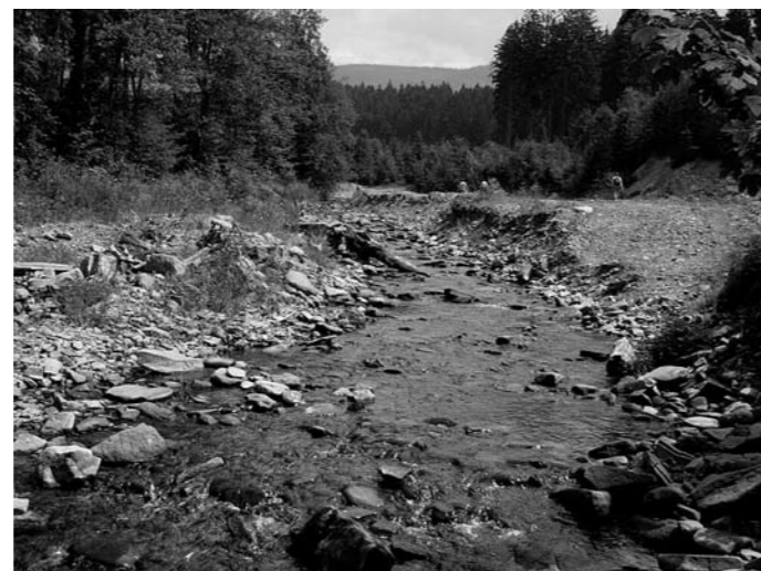
2003 - stav před zahájením revitalizačních úprav koryta. Štěrkové koryto bylo nestabilní a potok ohrožoval sousední pozemky a stavby.
