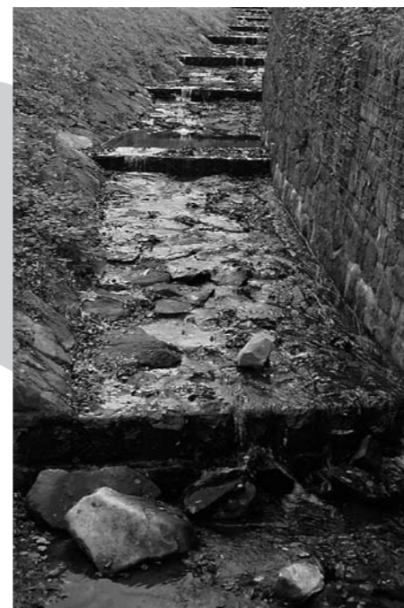
vodní tok je často degradován na koridor pro převod vody, který má zabírat co nejméně místa
