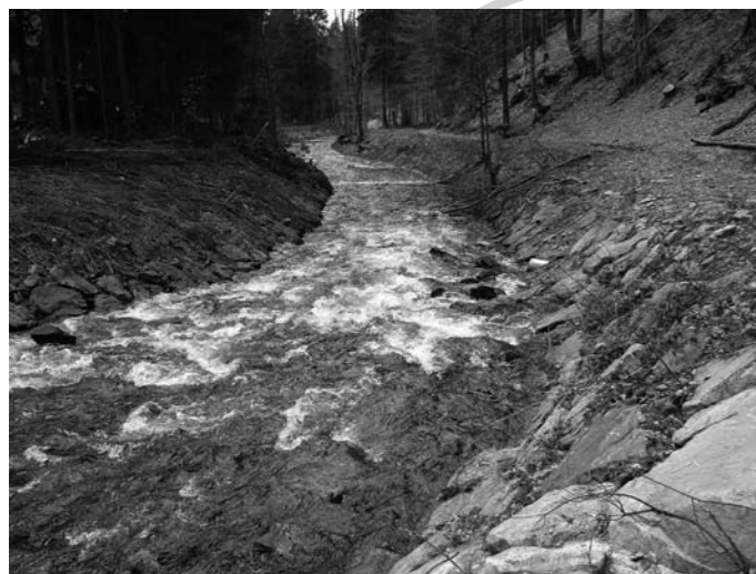
1997 - původní upravené koryto Kněhyňského potoka bylo lichoběžníkového tvaru a sloužilo především k rychlému odvedení vody z krajiny, po povodni v roce 1997 však bylo kamenné opevnění zcela zničeno a tok si našel novou trasu.
