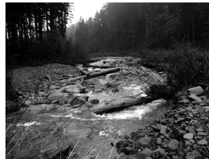
2010 - na části hlavního koryta došlo k pohřbení dřevěných stabilizačních prahů štěrkovými náplavami.
